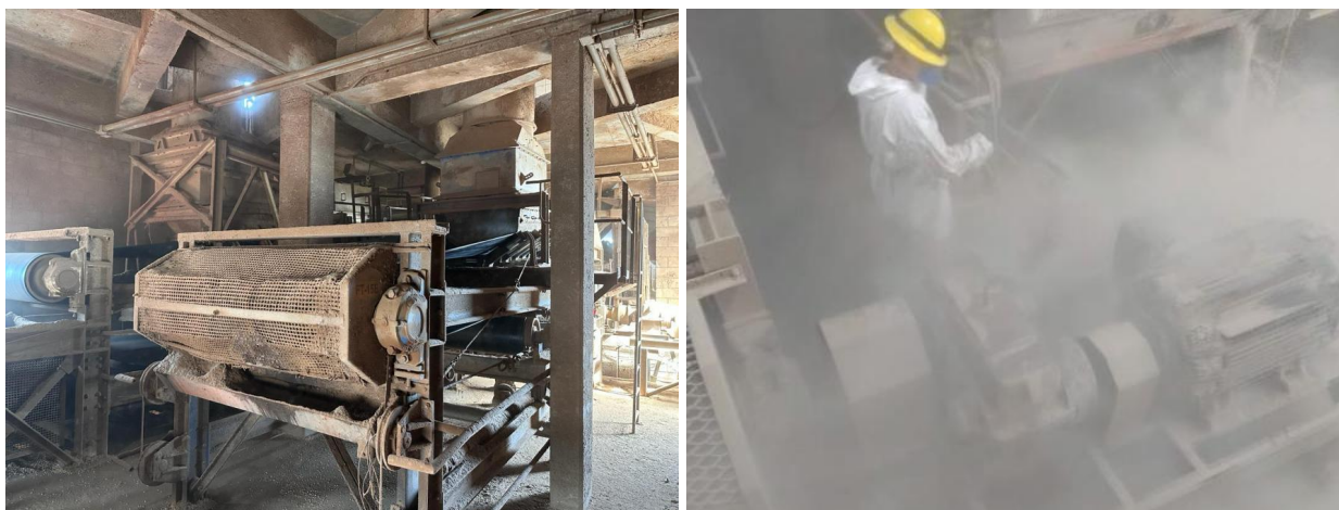
Figura 03: (Descarga de transferência entre FT14 e FT15)
