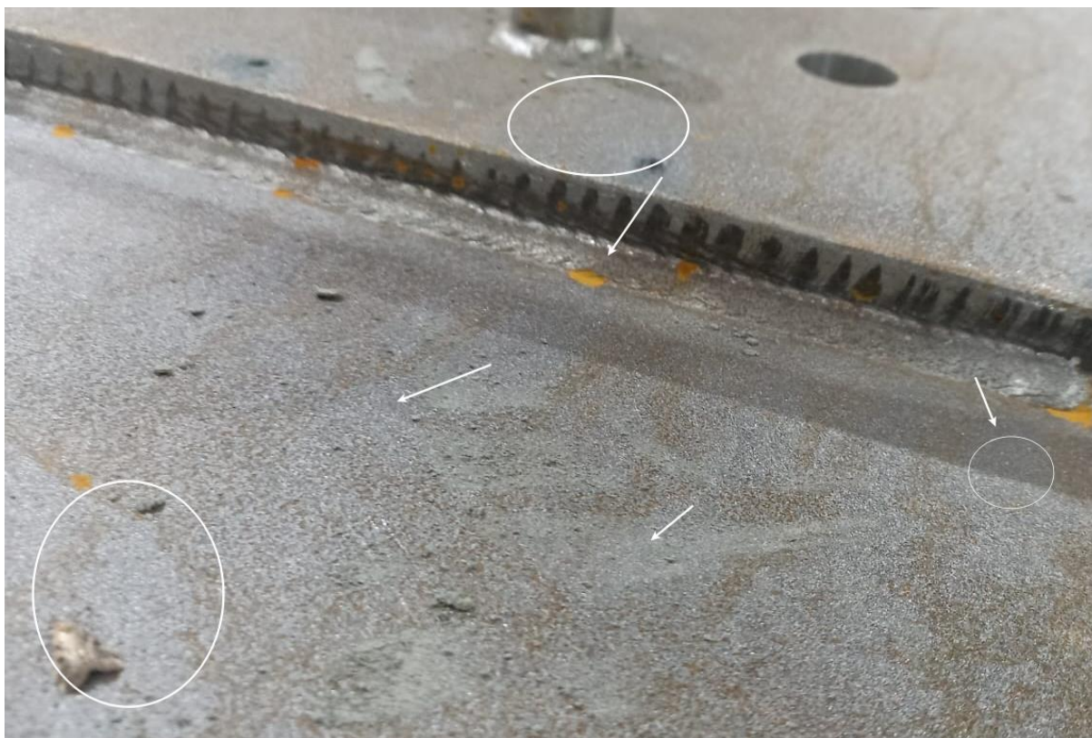
Figura 2. Resultados da limpeza de chapas de aço enviada pelo cliente.
