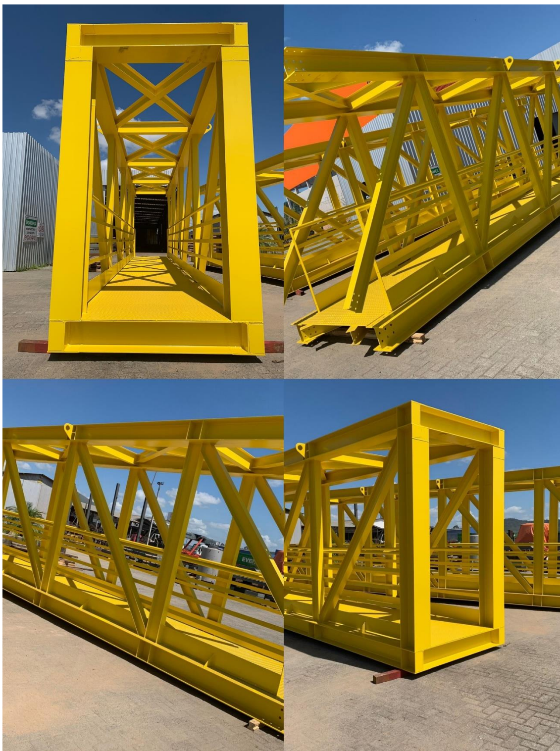
Figura 4. Resultado da aplicação do primer epóxi utilizando pistola de pintura
